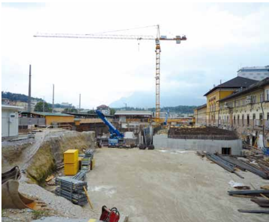
Hier entsteht die unterirdische Geschäftspassage, die Schallmoos und Elisabeth-Vorstadt verbinden wird.
