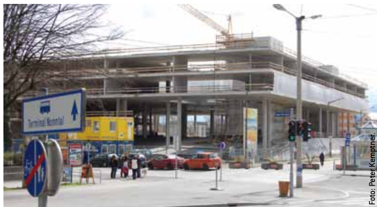
Erkennbare Fortschritte beim Bau des Unipark Nonntal.
